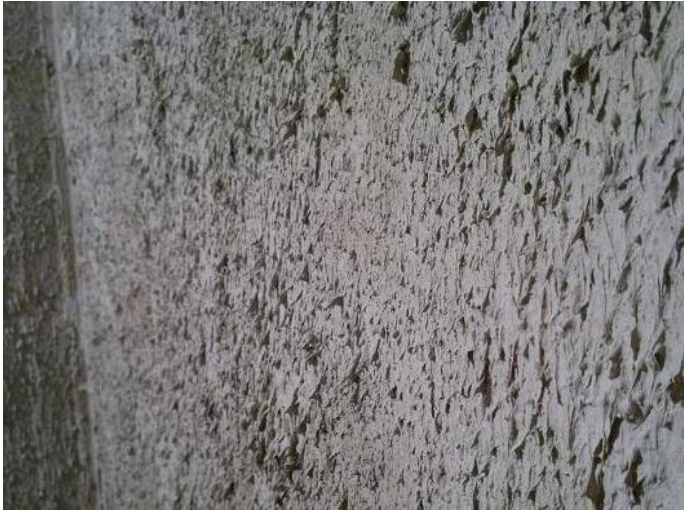
贴墙砖之前的水泥基层要拉毛
